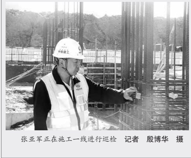
张亚军正在施工一线进行巡检 记者 殷博华 摄
