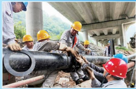
企业职工正在架设被洪水冲毁的尾矿管道
