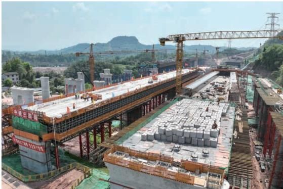
当日，由中铁四局承建的西渝高铁康渝段全线首联连续梁顺利完工，为后续连续梁施工奠定了基础。
