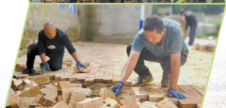
横山区党岔镇王家瓜村桥涵施工现场
