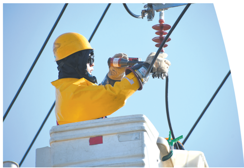
国网陕西电力员工为客户安装配变
