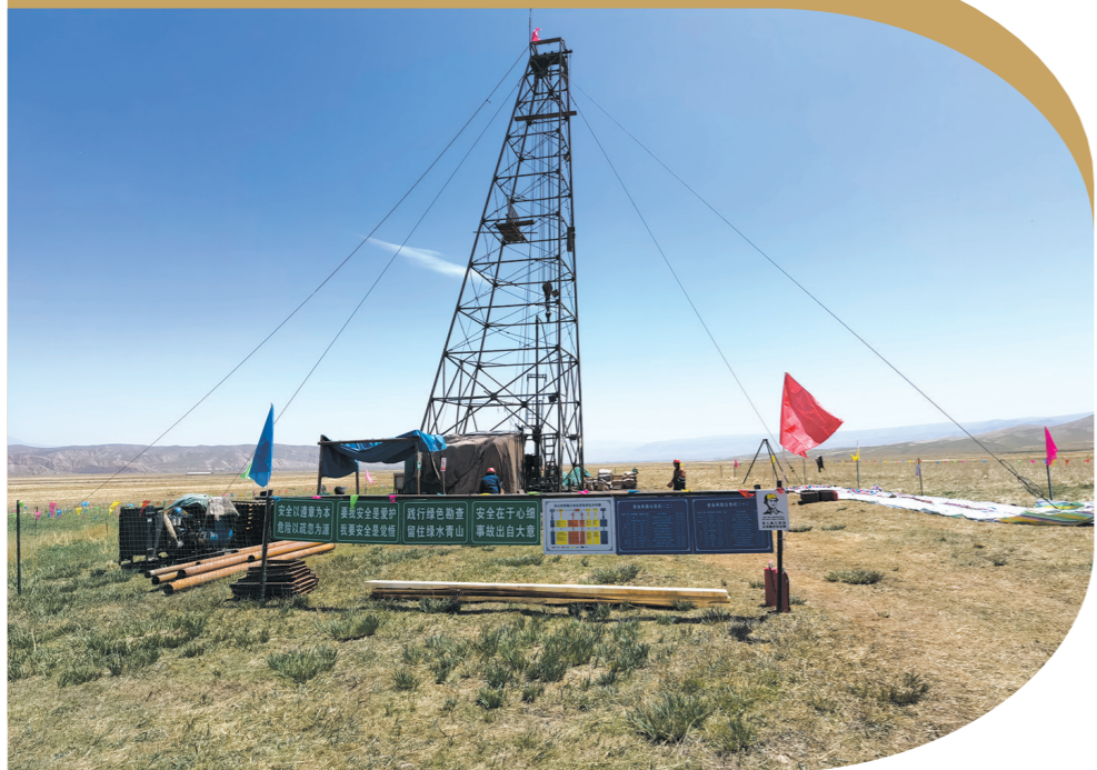
甘肃肃南县法拉沟煤矿外围煤炭详查1198.40米钻孔施工机台
